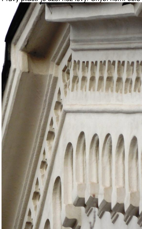
Pravý pilastr je užší než levý. Chybí horní oblé lišty, spodní lišta vpravo je, vlevo chybí.
