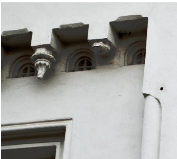
chybějící konzolka na zubořezu
