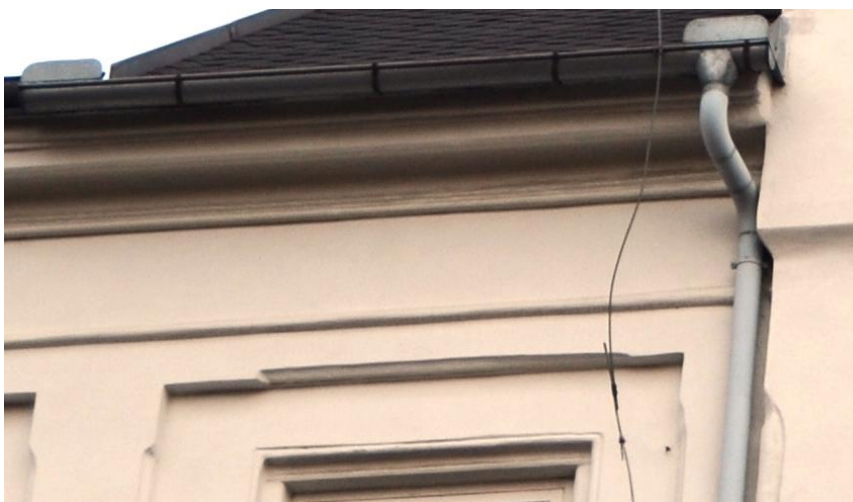
Lezénový rám a vodorovná oblá lišta na horní lezéně. Oblá lišta je pouze na lezéně na levé straně rizalitu, strana pravá lištu nemá. Bude doplněna i na pravou stranu.
