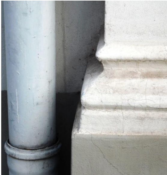
Soklové římsy na soklu pilastrů
