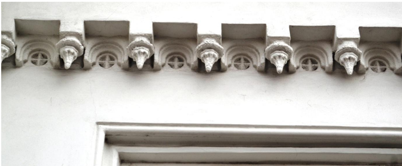
Podřímsové prvky konzolky, kazetky, okenní lemovací profil - zapuštěná šambrána gotického profilu, vodorovná hrana není zkosená
