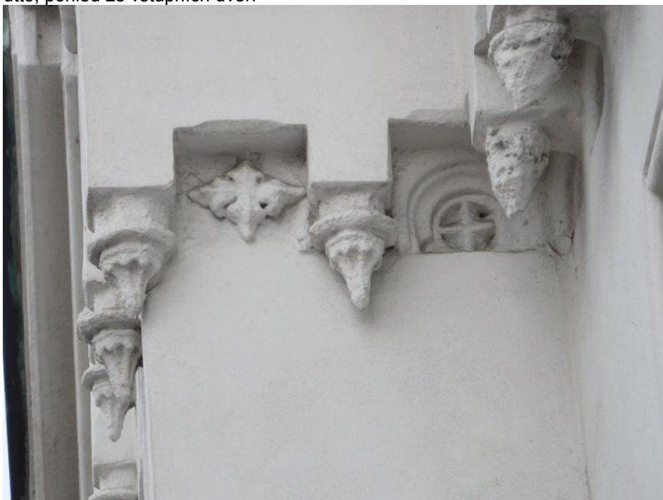
pravá boční strana, konzolky, kazetky, nepravidelnosti vlysu detail, lístek kamufluje, že se nevešla kazetka
