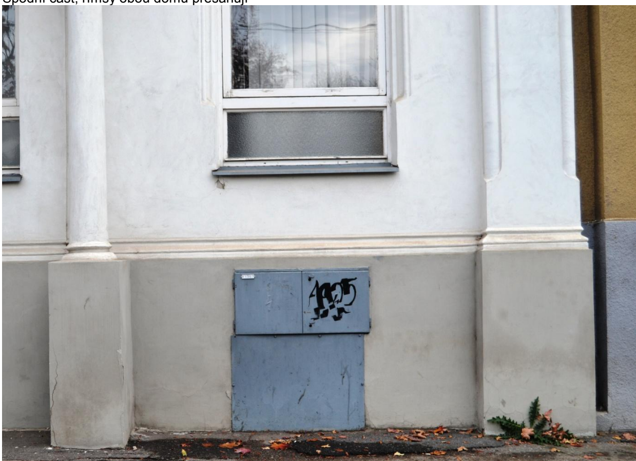
Ukončení soklu u souseda vpravo, elektrorozvaděč, pilastr, portálový soup
