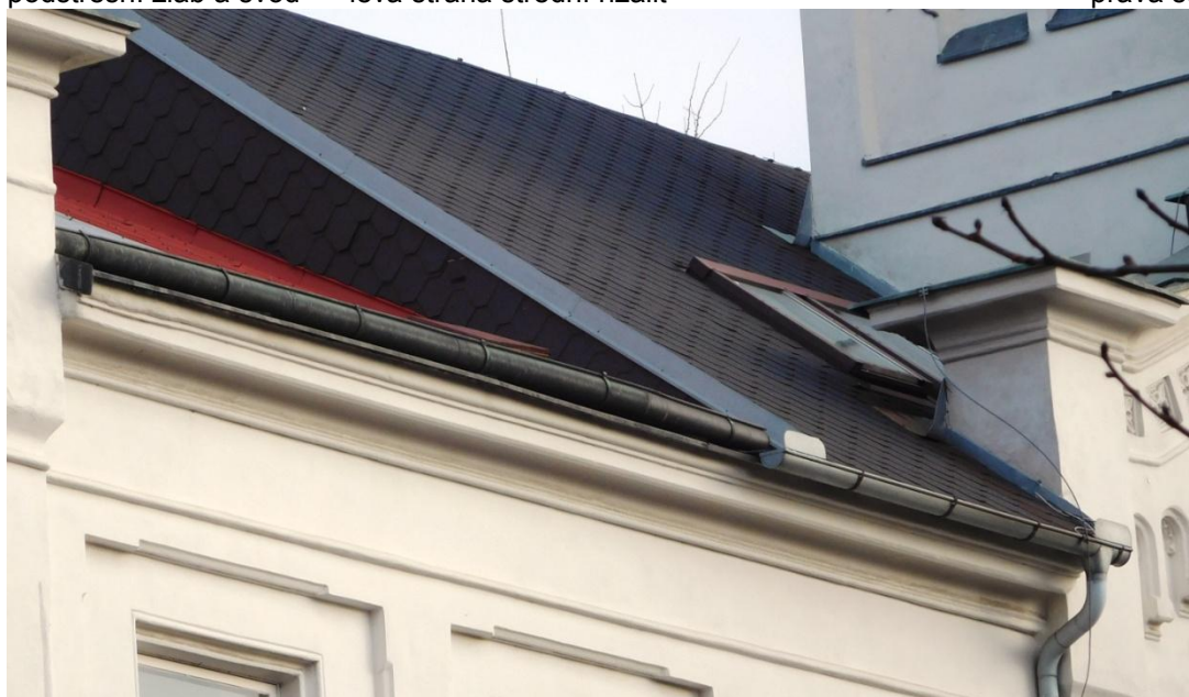
Problematická kombinace nástřešního a podstřešního žlabu
