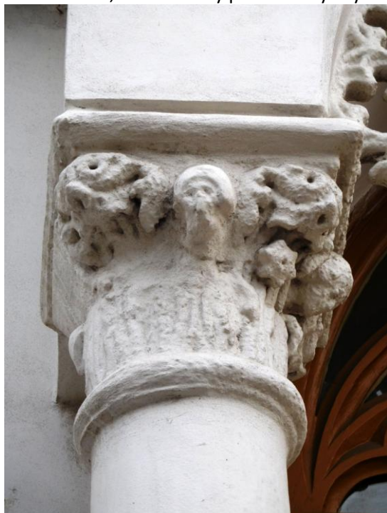
poškozená levá hlavice, štukatérská oprava, doplnění
