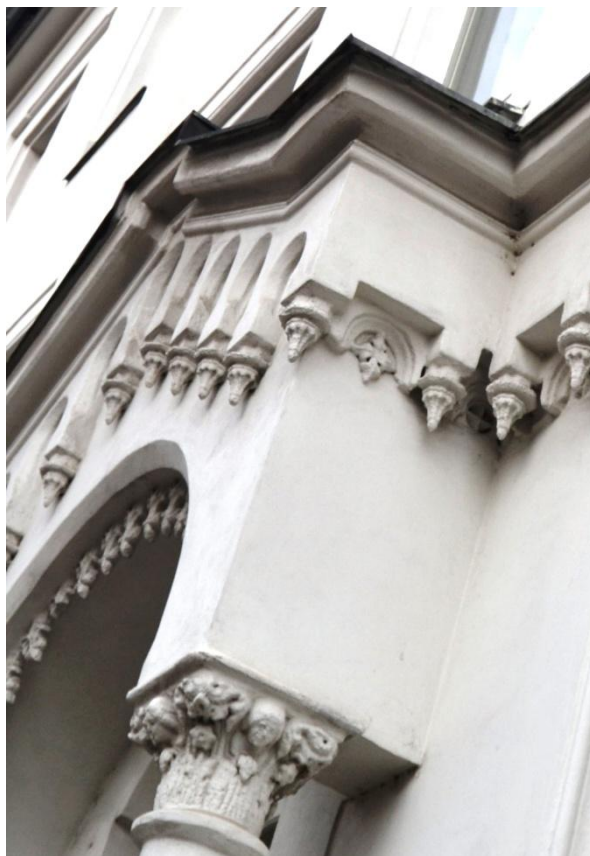
Pravá strana, kazetka vlysu je překryta lístkem aby byla zachována podobnost se středním portálem, kde byl lístek použit jako nouzová dekorace v prostorové tísní.
