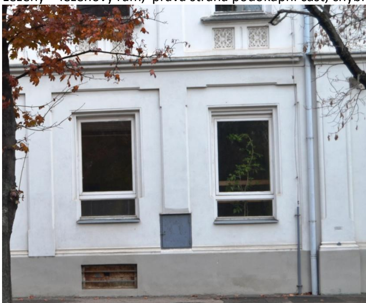
Lezény - lezénový rám, pravá strana podokapní část, chybí oblá lišta, bude doplněna
