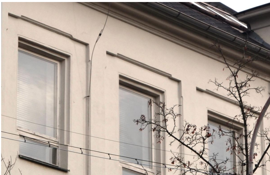
Lezény - lezénový rám, pravá strana podokapní část, chybí oblá lišta, bude doplněna
