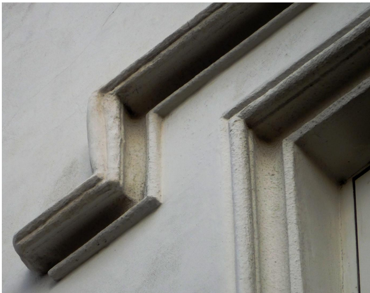
Nadokenní římsa – střední okno 2.NP, levý a pravý rizalit , šámbrána
