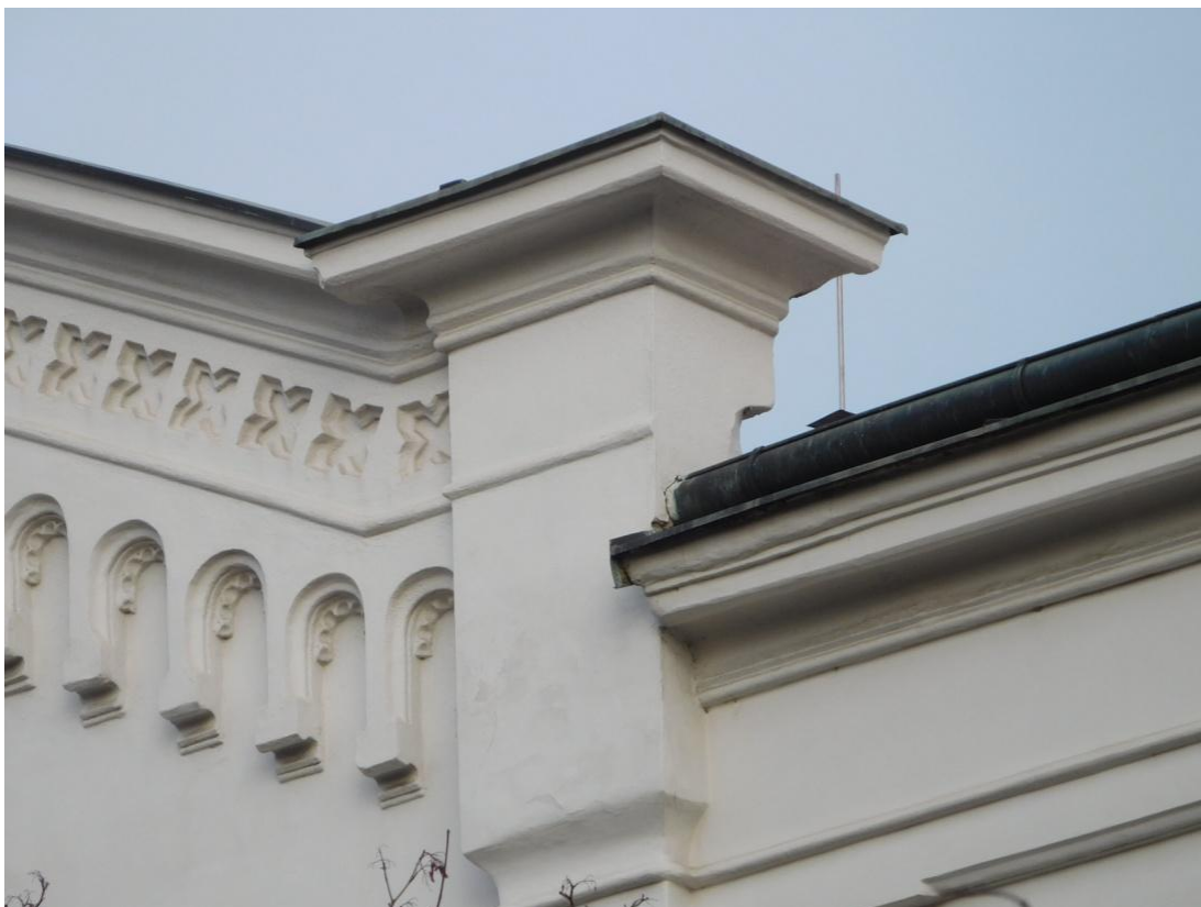
pravá atika, ukončení pilastru, nadstřešní okapový žlab , oblá lišta na lezéně navazuje na lištu na pilastru
