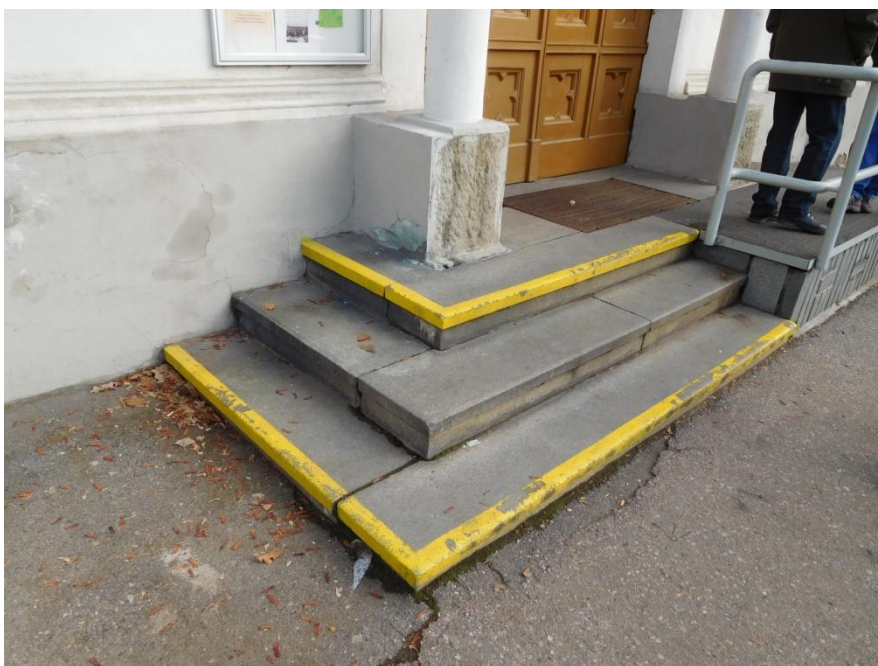
Předložené schody – pouze oprava osazení kamenných desek v návaznosti na stěnu.
