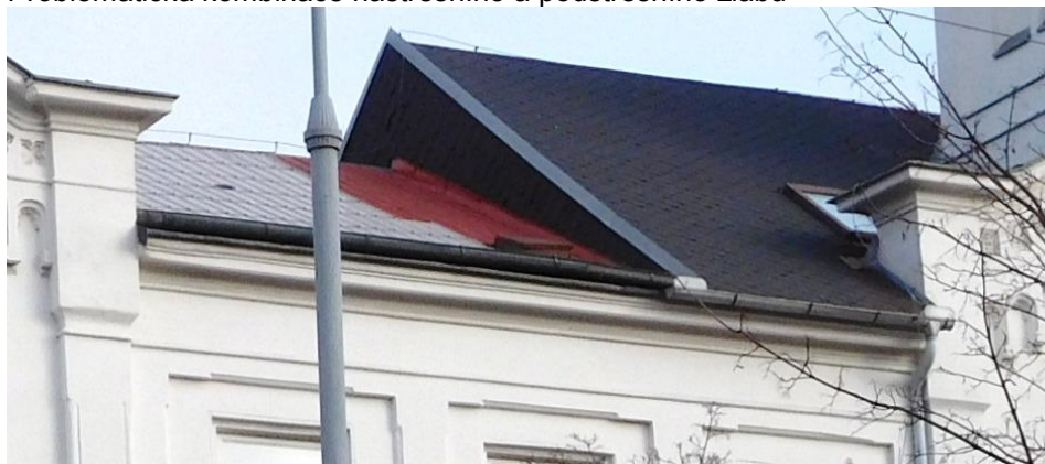
Nástřešní a podstřešní žlab mezi levým a středním rizalitem
