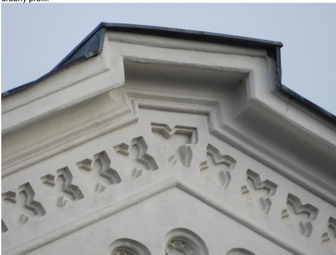
Vrchol štítu, římsa, negativně tvarované kazety. Kazety řadové – čtvercový kříž 250x250 mm , kazeta vrcholová
