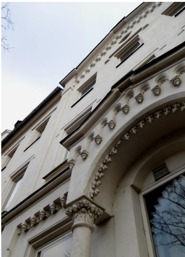
horní část portálu, levá strana byla zachována podobnost se středním portálem, kde byl lístek použit jako nouzová dekorace v prostorové tísní.
