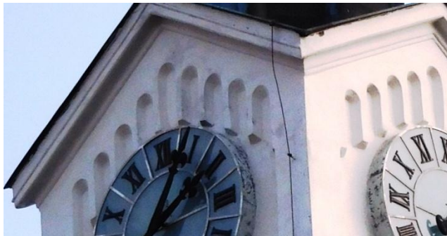
Jih a západ – obnovit profilaci obloučkového vlysu
