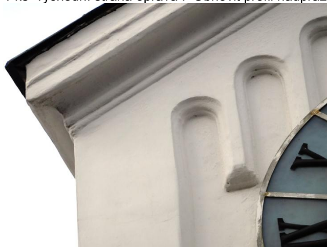
detail profilu římsy a detail obloučkového vlysu
