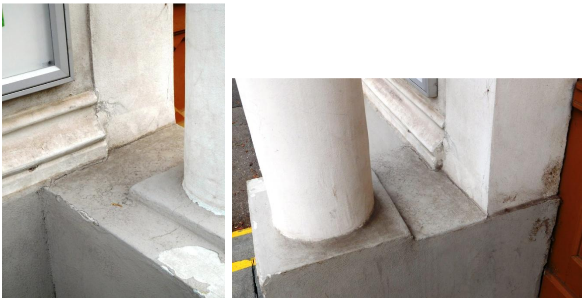
Detail napojení soklu pod sloupem portálu a soklu fasády. Esteticky, slohově i prakticky nevyhovující stav.
