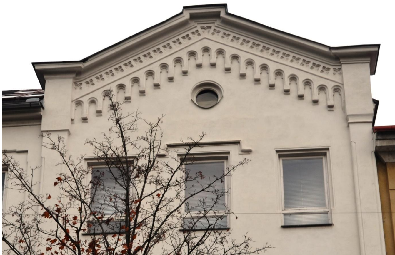
Pravý pilastr je užší než levý. Chybí horní oblé lišty, spodní lišta vpravo je, vlevo chybí.
