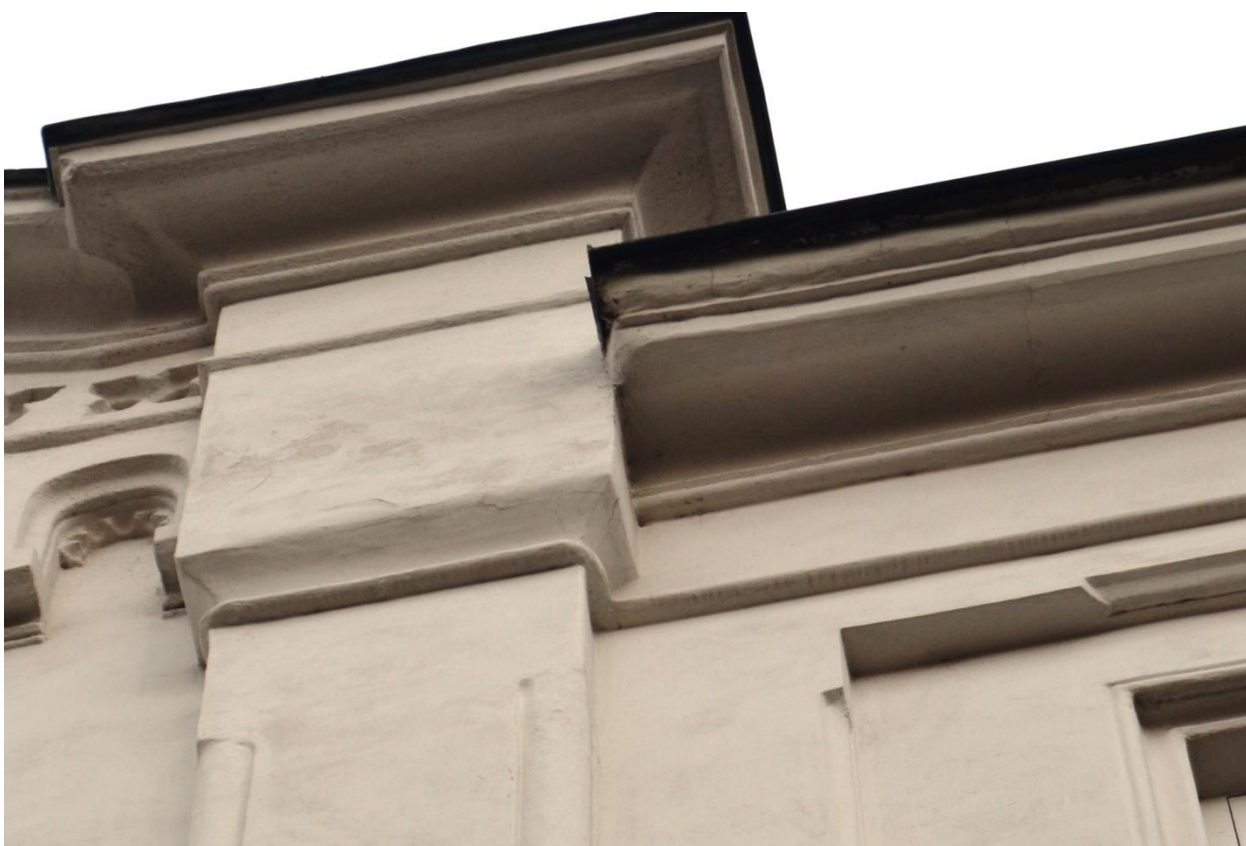
Na spodku atikového sloupku je odstraněn přechodový profil, vpravo detail lezénového rámu a okenní šambrány, pilastr s oblouny .
