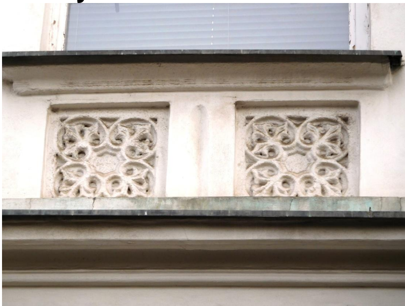
Parapetní plocha – 2. NP sestava 2 ks kazeta, svislý profil, parapetní římsa.
